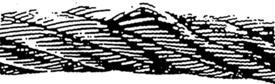
slijtage = verlies van materiaal, onregelmatig oppervlak
